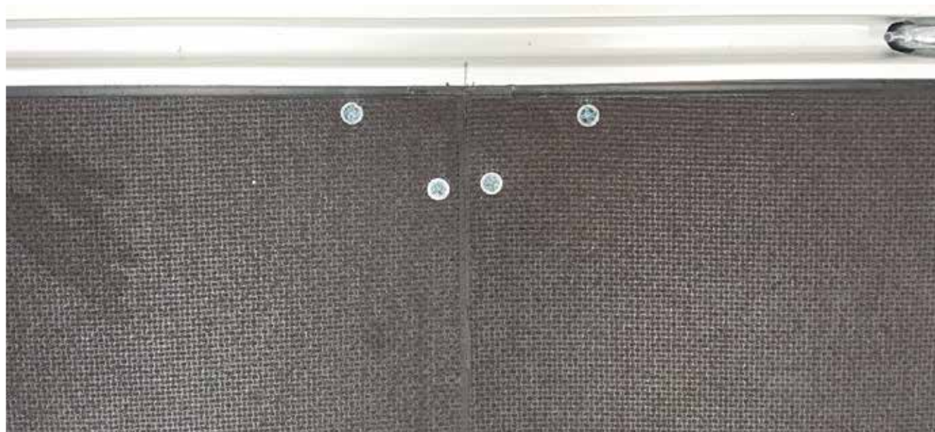
Wisa-Wire helyes alkalmazási példa (süllyesztett csavarfejek, tömített éttalálkozások)
